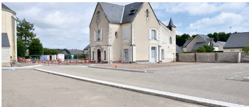
► Aménagement de places de parking côté presbytère
