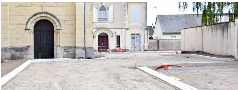
▶ Réaménagement et renaturation de la place Auguste Harrault
