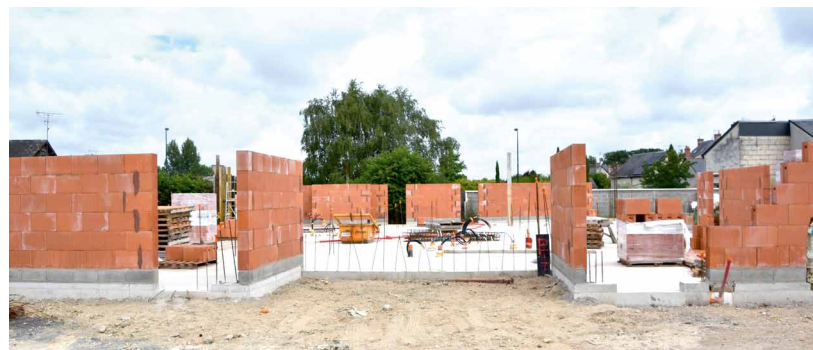
► Démarrage des travaux de la future maison médicale
