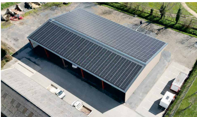
▶ Vue aérienne du nouveau batiment des services techniques équipé de panneaux solaires
