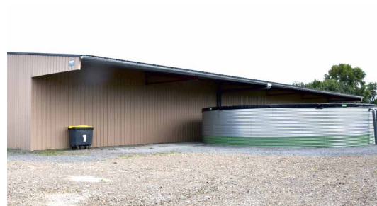
▶ Nouveau bâtiment des services techniques implantation d'une réserve d'eau du 200m 3
