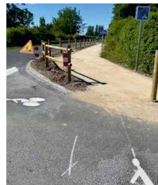
▶ Aménagement liaison douce quartier des Hopiaux
