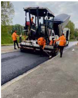
▶ Reprise des enrobés, rue nationale
