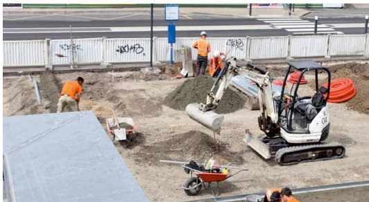
▶ Travaux bords de la rue nationale accès place Auguste Harrault
